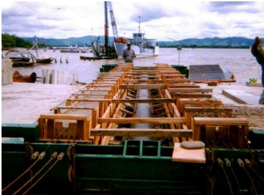
Prefabricación de elementos en concreto y banco de tensionamiento in situ
