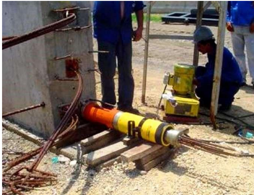
Montaje de losas prefabricadas y tensionamiento de vigas de 20m de longitud
