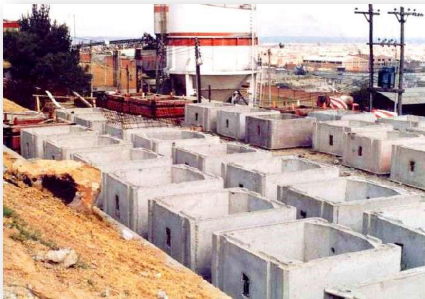
Proceso Constructivo y Almacenamiento
