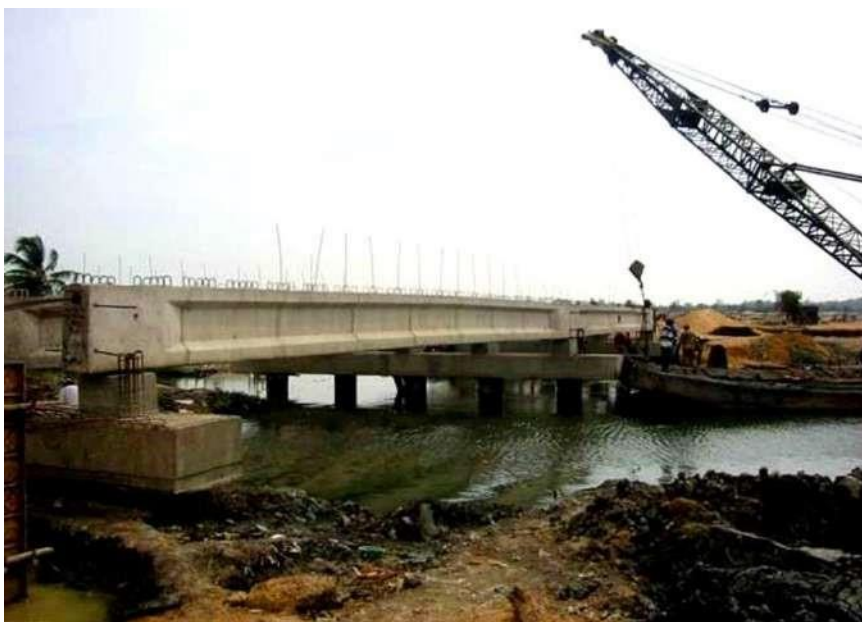
Equipo de pilotaje sobre bongo de 350 Ton y montaje de vigas
