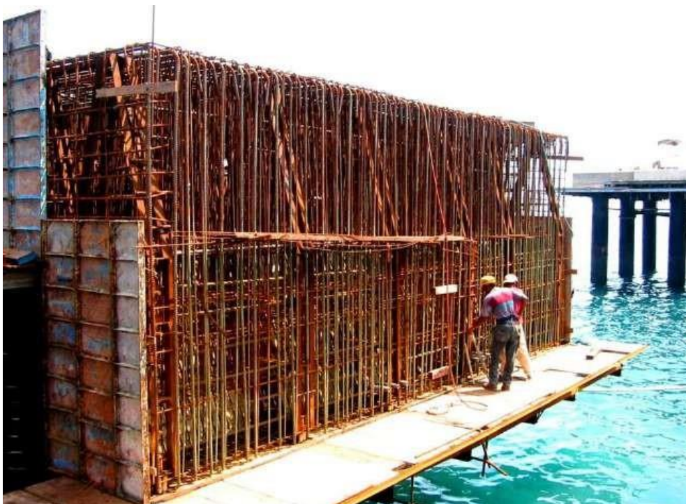
Fundida de 340 m 3 de Concreto Para Cada Duque del Alba del muelle
