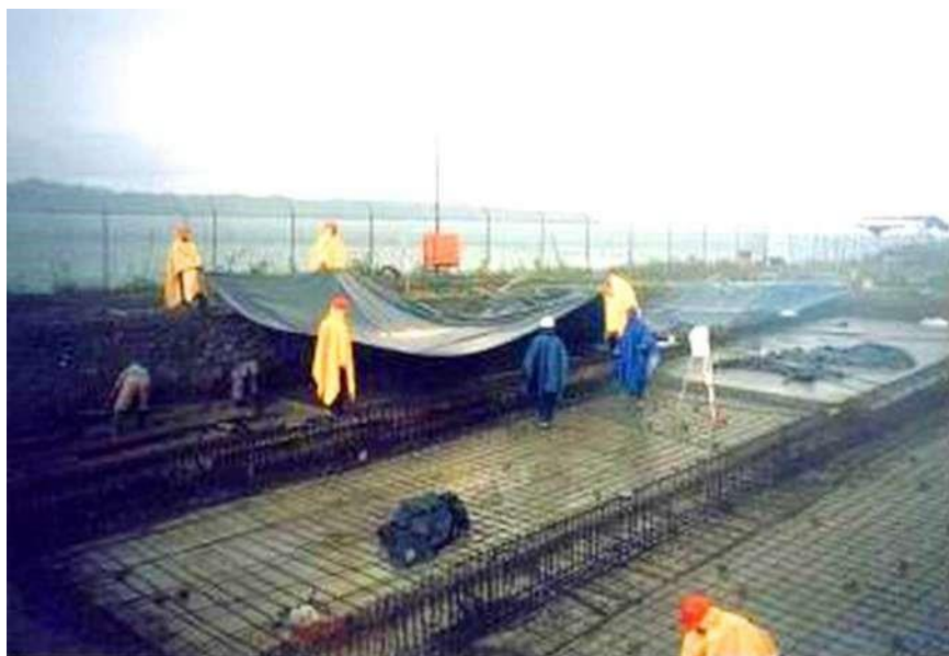
Protección de trabajos bajo lluvia intensa
