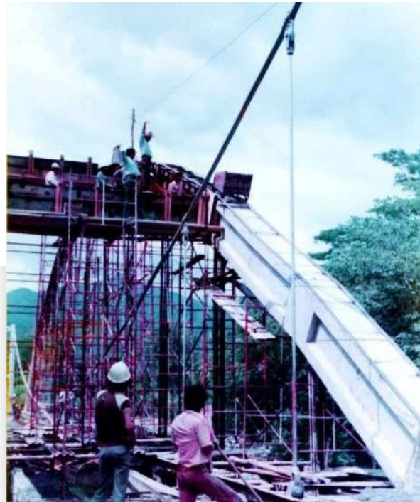
Fundido con Sistema de Cargadores Sobre Rieles Construcción de Arco Portante con Unica Luz de 75 metros Puente Rio Sevilla – Via Fundación – La Ye
